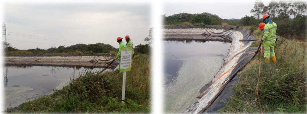
Figura 4. Bombeo de lixiviados de la piscina N°5 al reactor UASB
