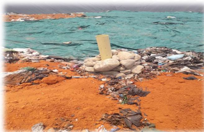
Figura 3. Chimenea ubicada en la Trinchera N° 13
