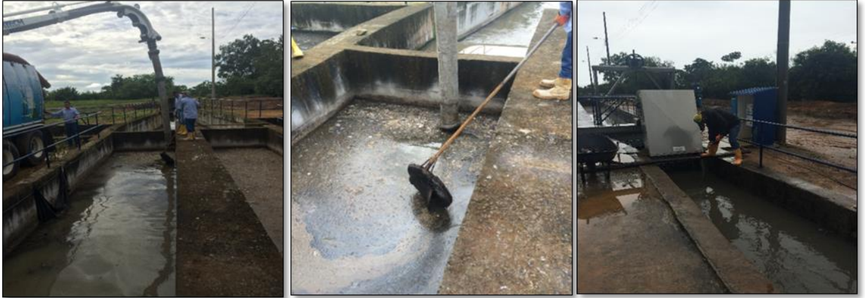
Imagen 2: Mantenimiento Desarenadores (Retiro de Sobrenadante) y Limpieza de Rejillas
