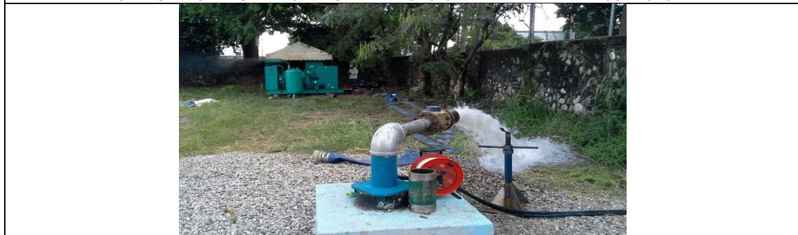
SE REALIZA BOMBEO PARA LLEVAR A CABO EL DESARROLLO DEL POZO, INICIALMENTE SE INSTALA EL GRUPO ELECTROGENO DE 300KVA 440-460V/60HZ PARA ENERGIZAR EL SISTEMA.
