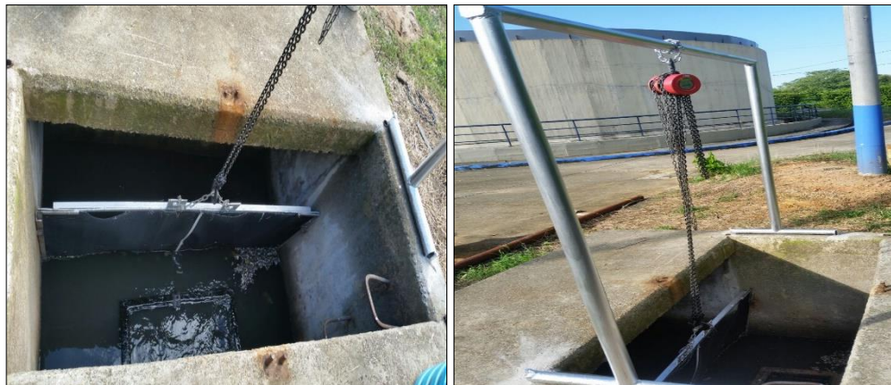
Imagen 7: Rejilla tipo cortina entrada tanque de bombeo filtros percoladores
