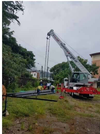
ALISTAMIENTO DE GRUA TIPO PH PARA INMERSION DE EQUIPO SUMERGIBLE Y TUBERIA DE PRODUCCION.
