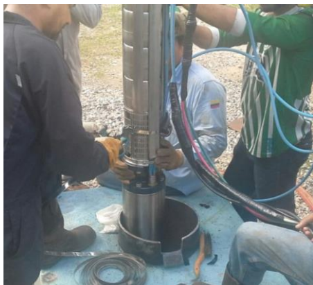
INMERSION DE ELECTROBOMBA SUMERGIBLE, CONDUCTORES DE FUERZA Y TUBERIA DE PRODUCCION.
