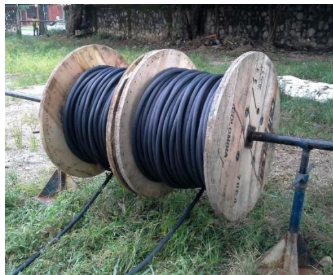
CARRETES CONDUCTORES DE FUERZA PARA ENERGIZACION DE ELECTROBOMBA SUMERGIBLE
