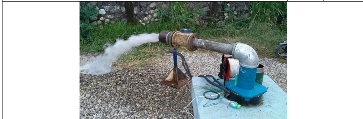
PRUEBAS INICIALES DE BOMBEO: VERIFICACIÓN DE NIVEL DINÁMICO Y CAUDAL.
