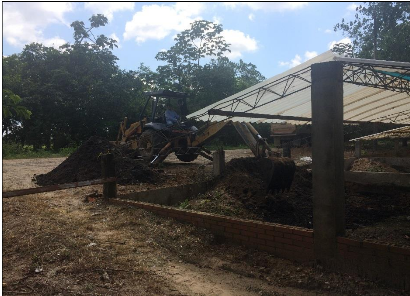
Imagen 10: Retiro Lodos Lechos de Secado
