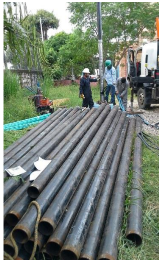
ALISTAMIENTO TUBERIA DE PRODUCCION Y CONEXIONADO DE ELECTROBOMBA TIPO LAPICERO
