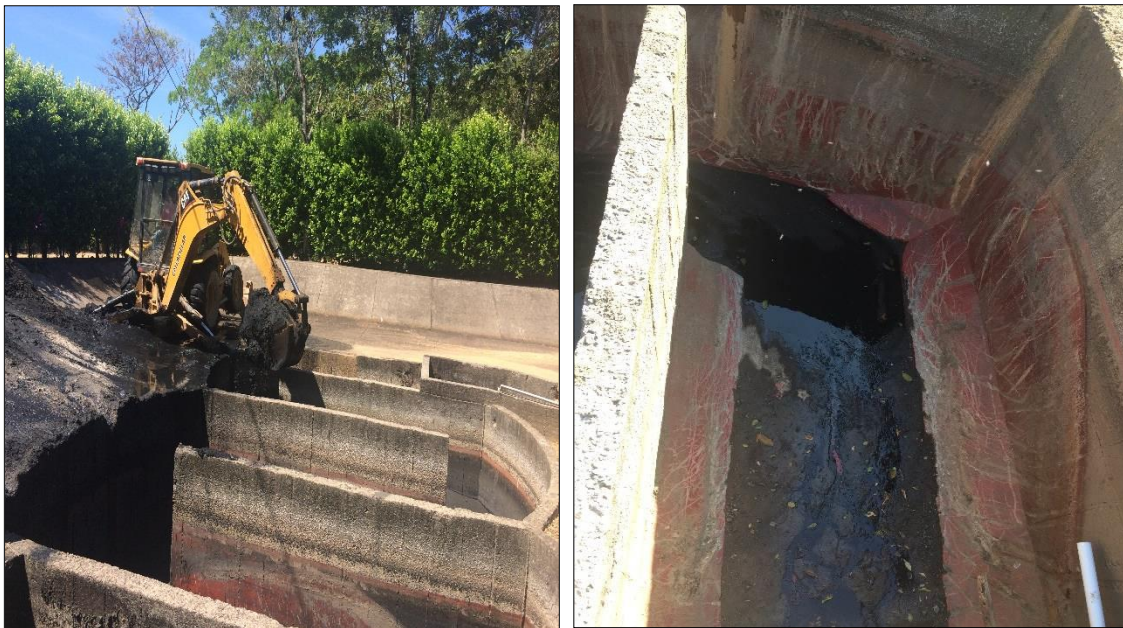
Imagen 4: Puesta en Operación Sistema de Pre Tratamiento Antiguo
