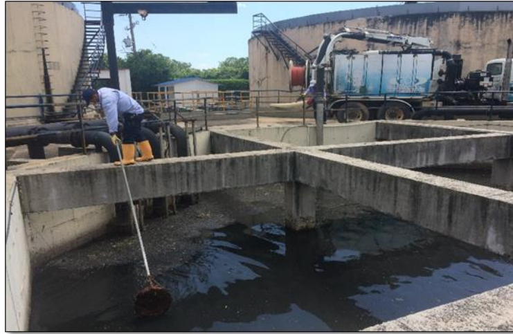
Imagen 8: Retiro de Sobrenadante Tanque de bombeo.
