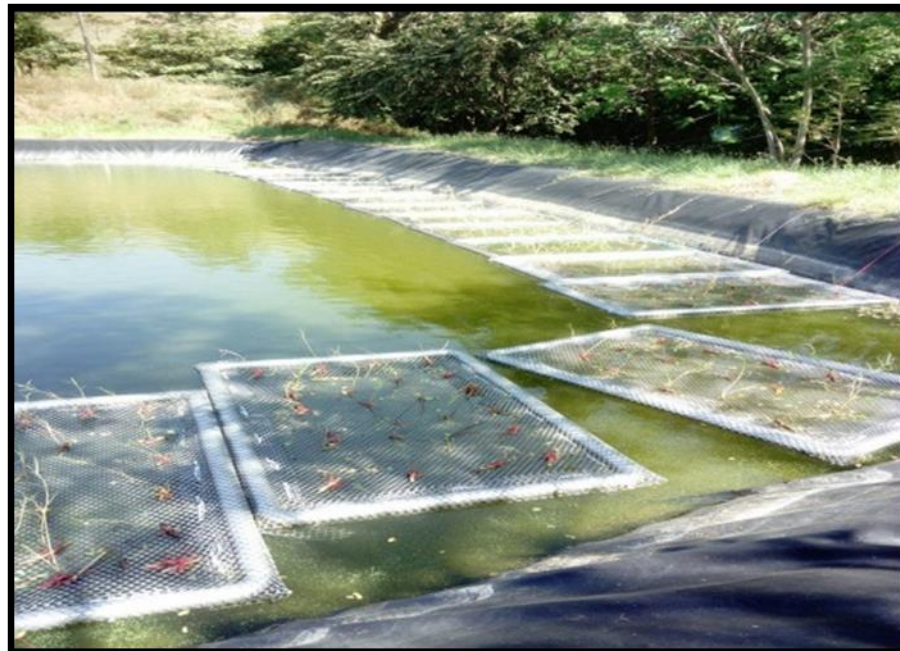
Foto 2. Sistema de fitorremediación en piscina de lixiviados
