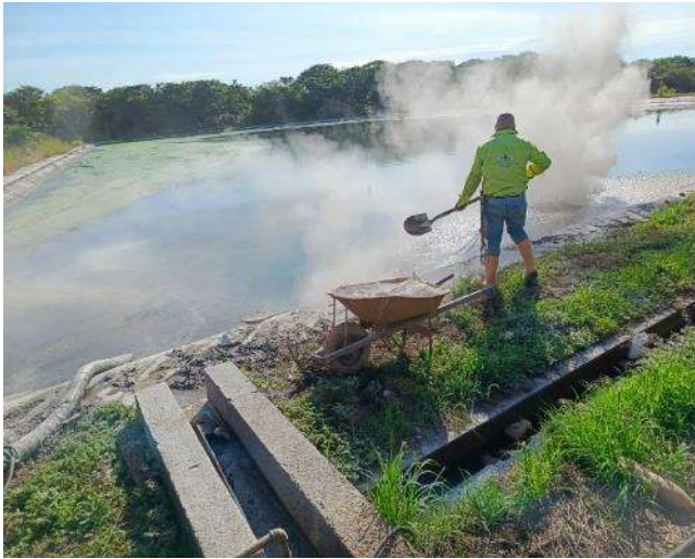
Aplicación de cal
