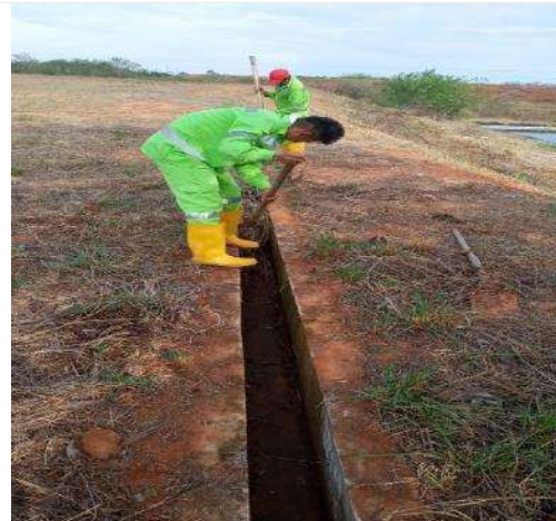
Canales perimetrales Manejo de Aguas Iluvia
