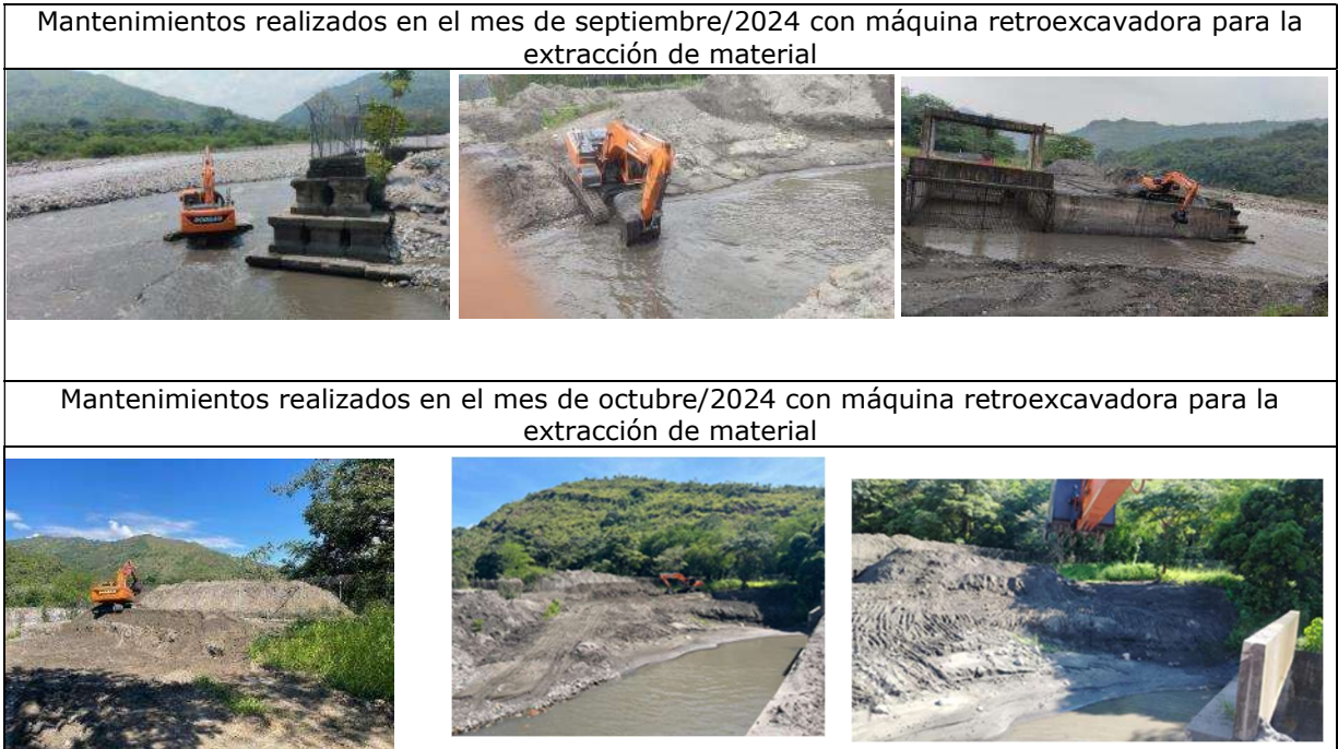
Ilustración 19 Mantenimiento en bocatoma cravo sur
