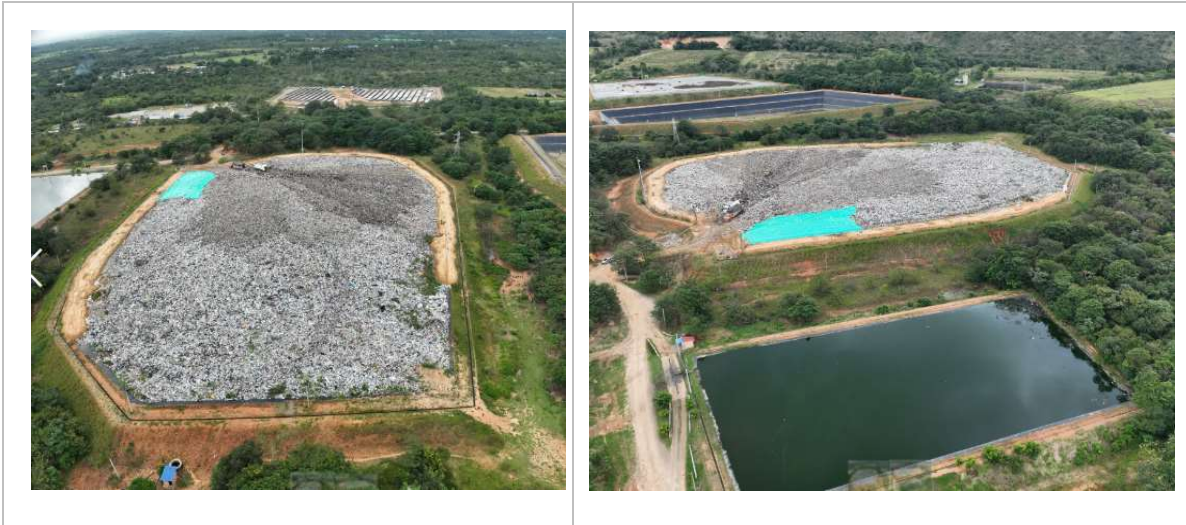
Ilustración 43 Trinchera 10 - Relleno Sanitario El Cascajar
