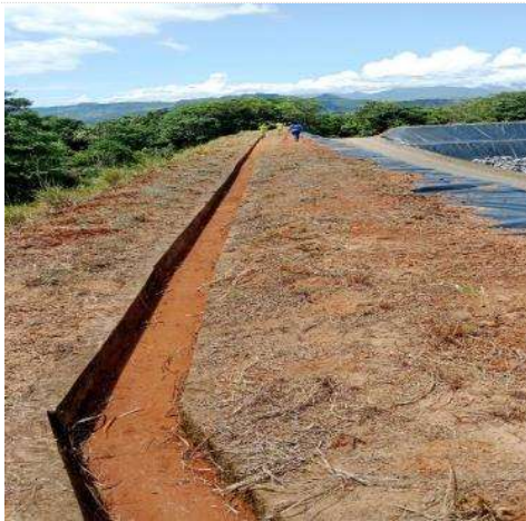
Canales perimetrales Manejo de Aguas Iluvia
