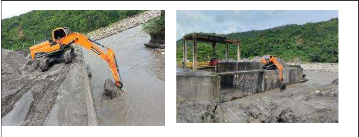
Ilustración 26 Mantenimientos realizados en el mes de julio/2024 con máquina retroexcavadora para la extracción de material
