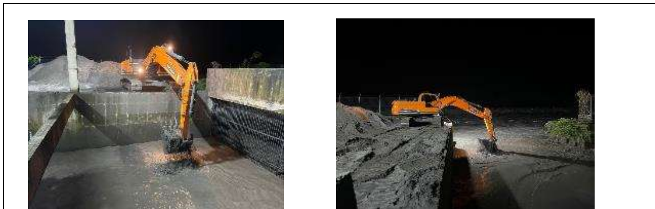
Ilustración 25 Extracción de material acumulado en bocatoma con apoyo de máquina retroexcavadora
