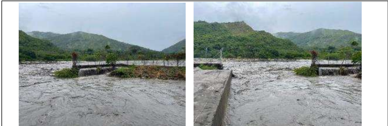
Ilustración 22 Aumento del nivel del Río Cravo Sur en el canal de entrada de la bocatoma el día 30 julio/2024
