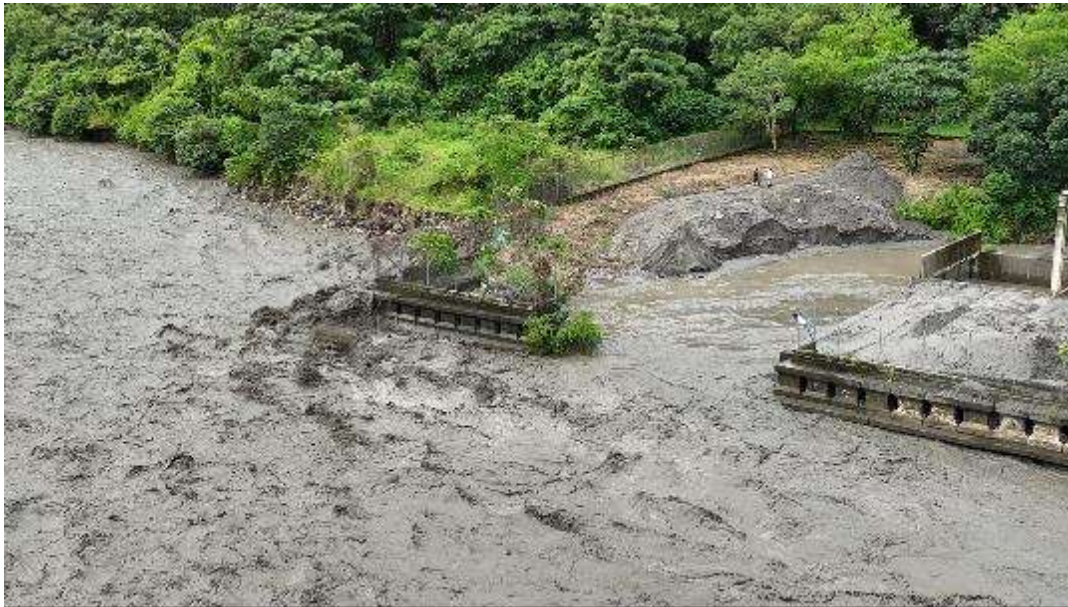
Ilustración 43 Zona de bocatoma Registro fotográfico tomado el 30/07/2024
