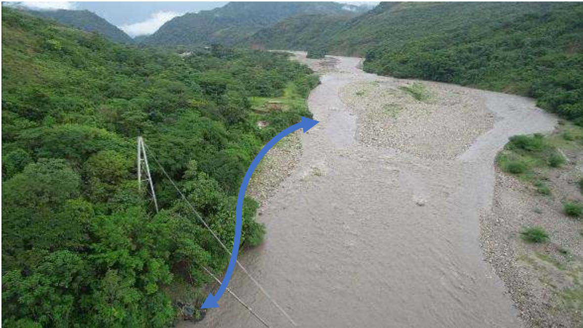
Ilustración 20 Desde el paso elevado el viejo hasta la Bocatoma
