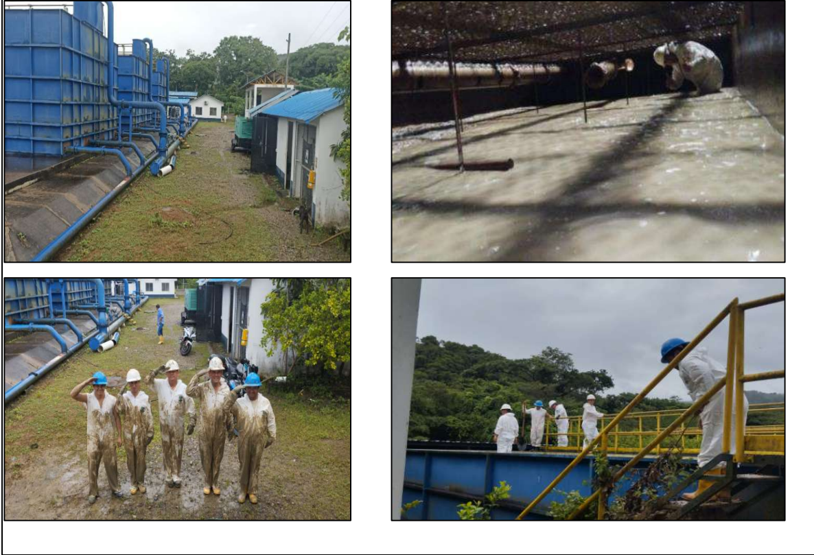
Ilustración 39 El 30 de mayo se prestó apoyo en el lavado de estructuras de la planta alterna – conciliada.
