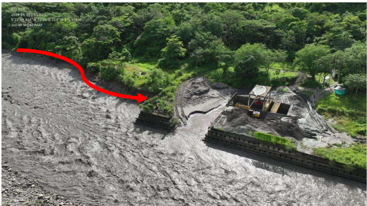
Ilustración 49 Rio Cravo Sur - Captación
