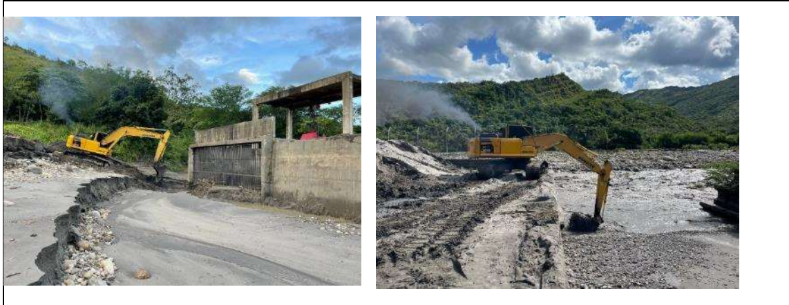
Ilustración 7 Extracción de material de río en bocatoma el día 16 de junio/2024
