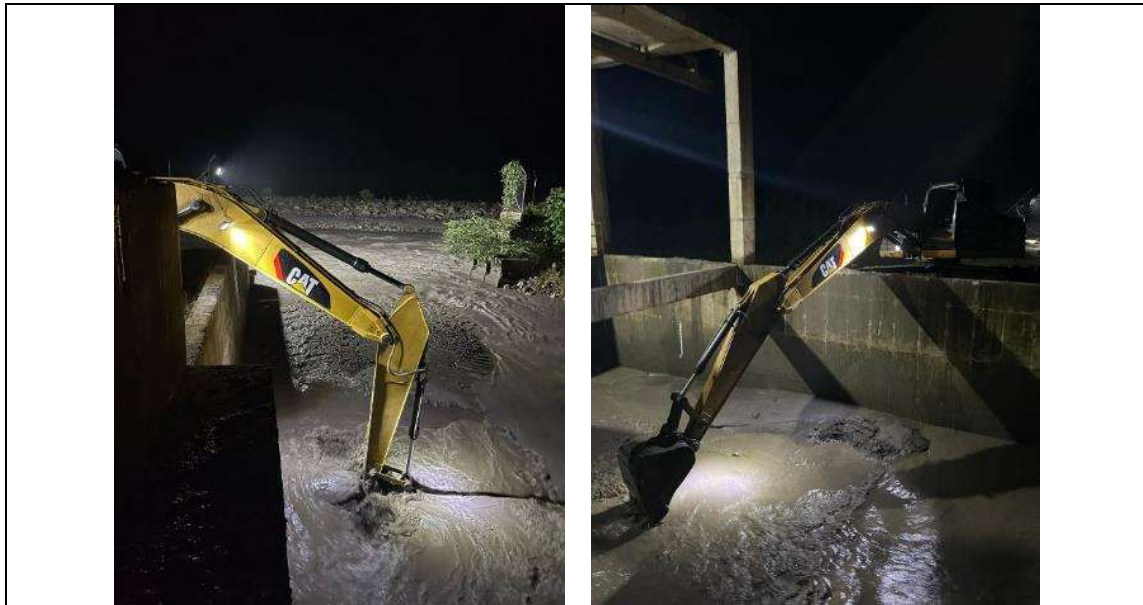
Ilustración 3 Extracción de material en bocatoma
