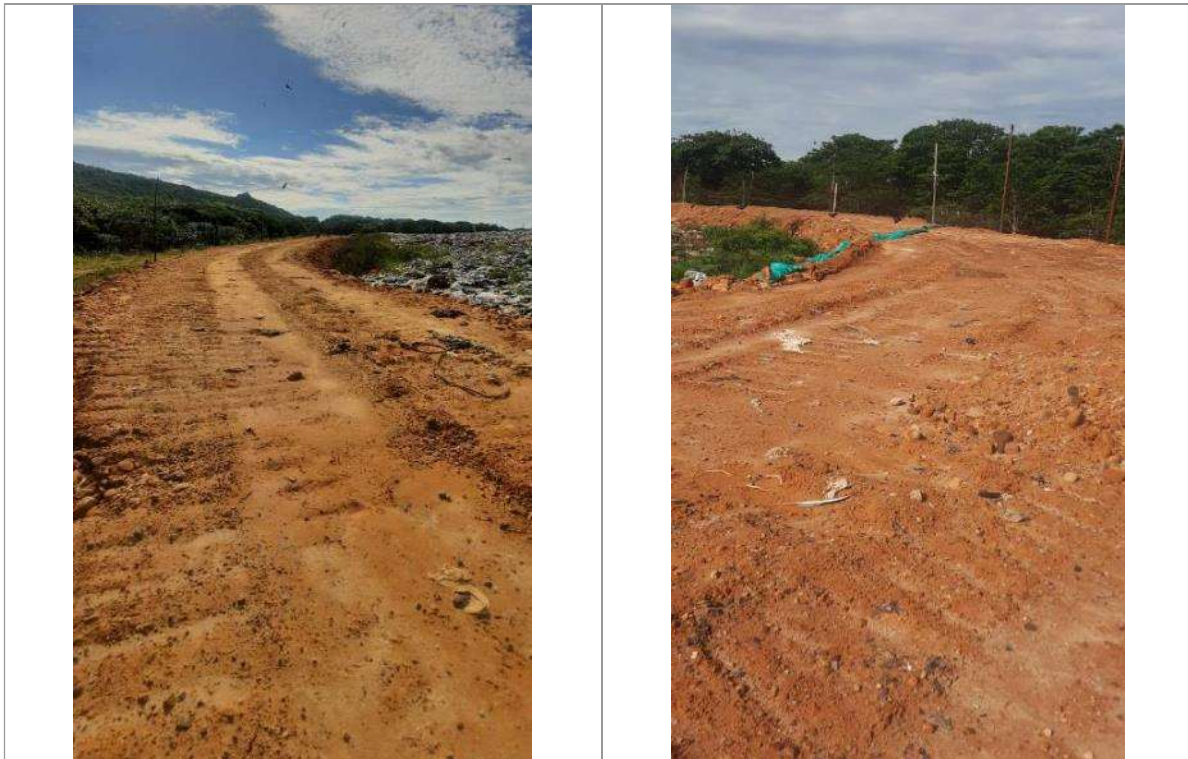
Ilustración 52 Jarillón perimetral trinchera 10
