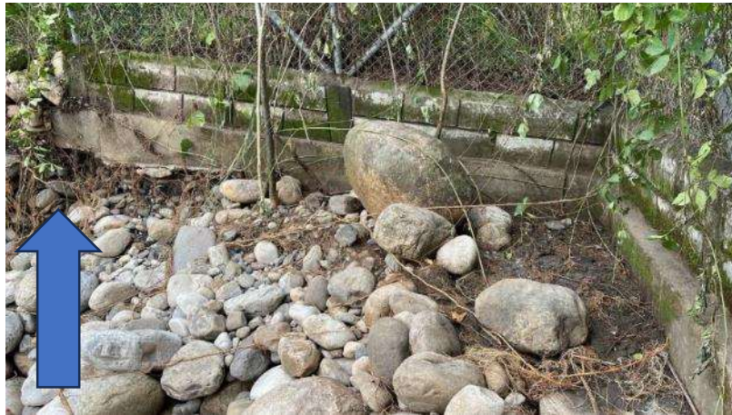
Ilustración 51 Cerramiento PTAP definitiva
