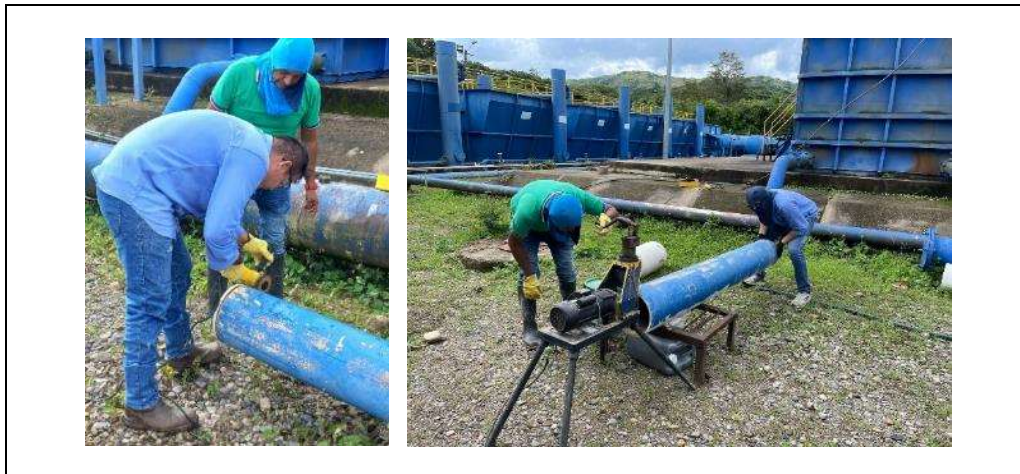
Ilustración 29 Reparación de tubería de 10 pulgadas de hidrociclones. 26 de Junio/2024.
