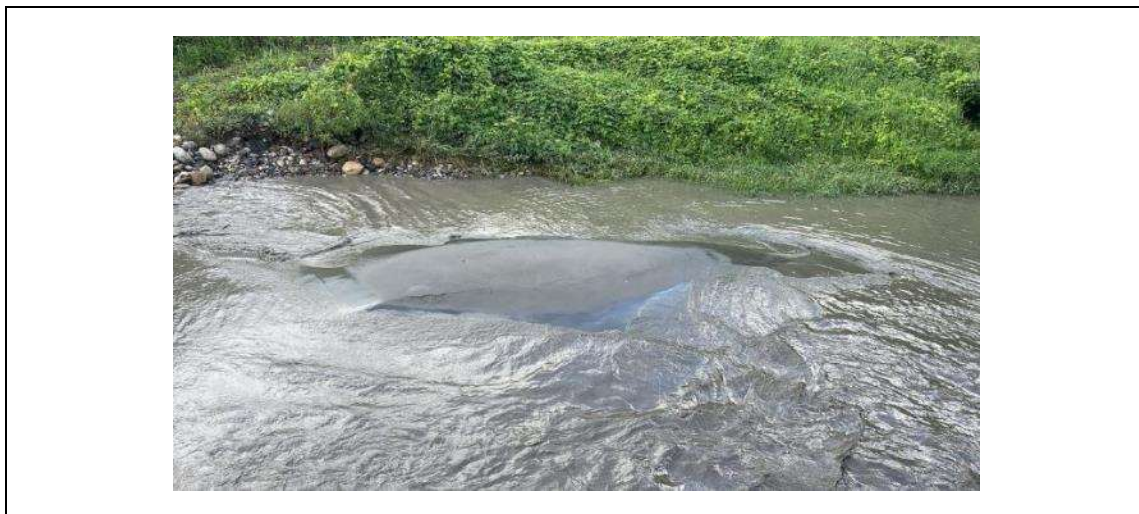
Ilustración 2 Sedimentación/colmatación de material en bocatoma el día 29 de mayo/2024
