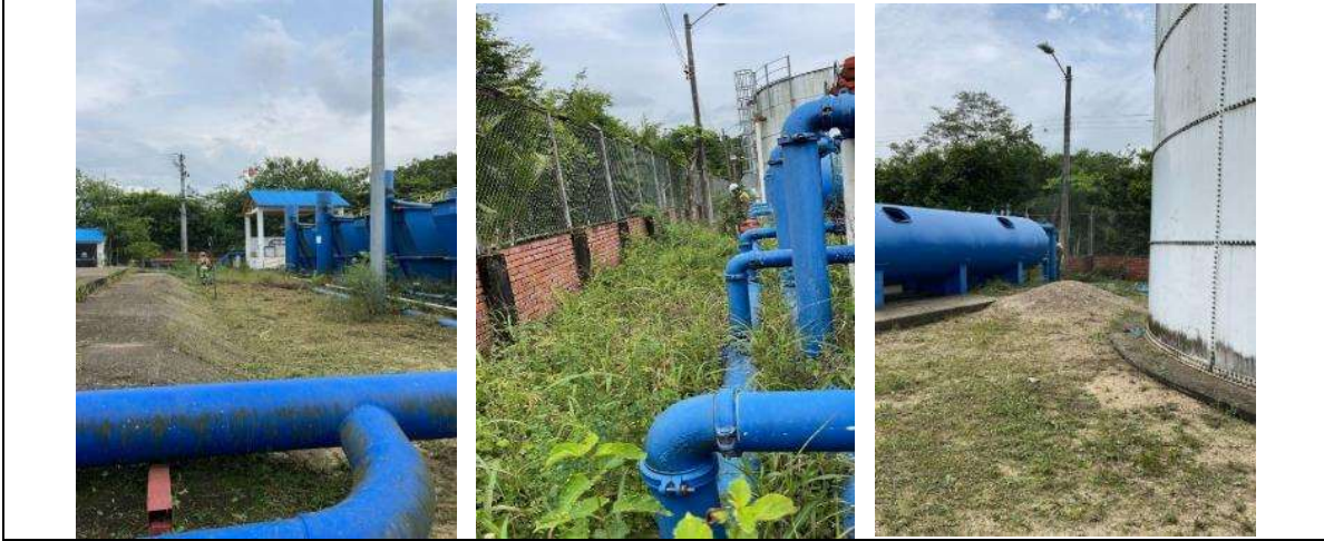
Ilustración 22 Actividad de guadaña en Planta Alterna
