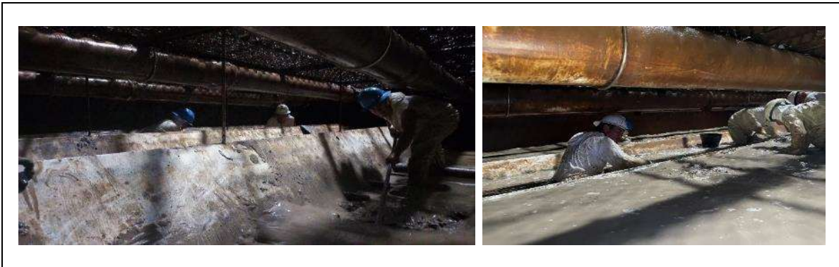
Ilustración 23 Lavado interno de tanques clarificadores
