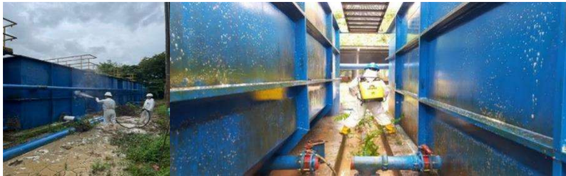
Ilustración 25 Lavado externo de tanques clarificadores. 17 de Junio/2024
