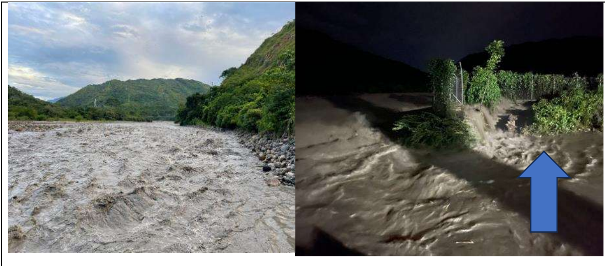
Ilustración 50 Impacto directo y de frente del cauce del río Cravo sur a la infraestructura.
