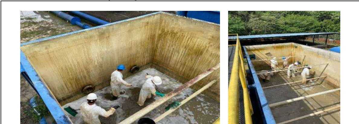
Ilustración 23 Lavado interno de tanques clarificadores
