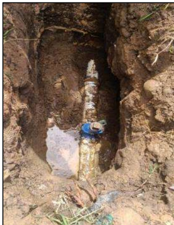
Ilustración 42 Instalación de válvula
