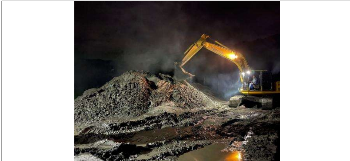
Ilustración 8 Extracción de material de río en bocatoma. Jornada noche.
