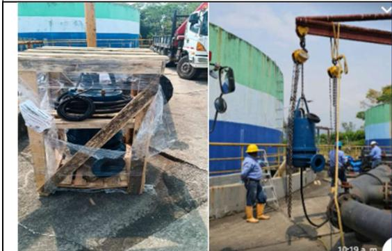
Instalación de dos bombas de 36hp y dos arrancadores suaves posición 2 y 5 de filtros percoladores.
