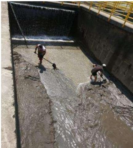
*Ilustración 13 LAVADO INTERNO DE TANQUES DE DESARENACIÓN*
