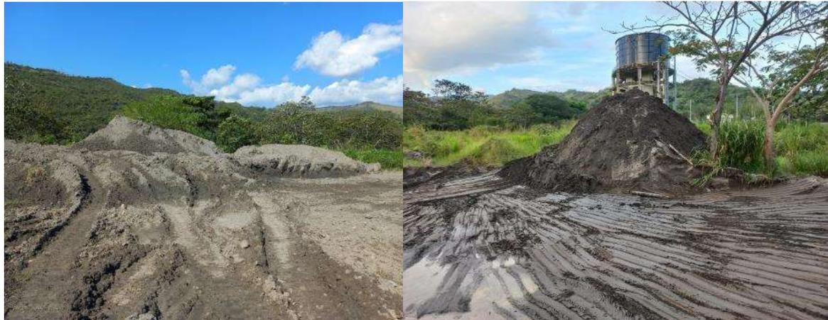
*Ilustración 17 Replanteo y despeje de áreas acumuladas de arenas.*
