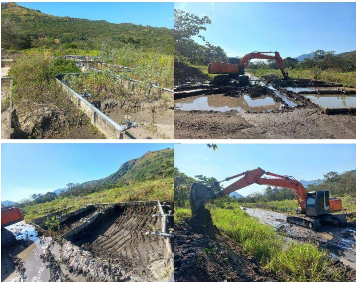
Ilustración 19 Extracción de arenas en lechos de secado
