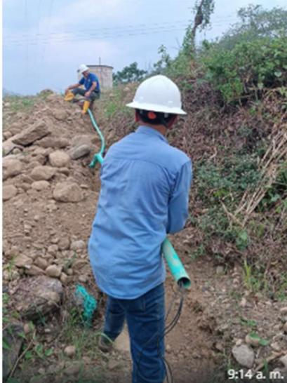
Se realiza excavación para la recuperación de tablero de control de macro de salida
