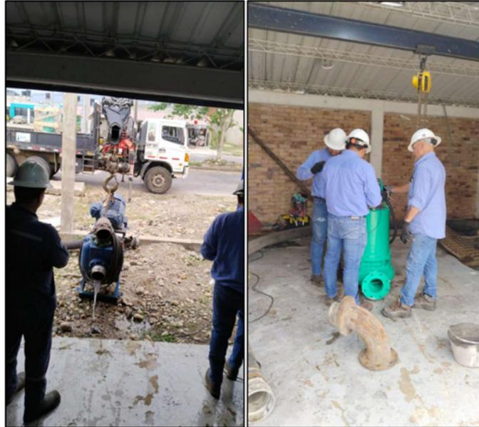
Ilustración 40 Reposición de electrobomba en EBAR Villa Lucia
