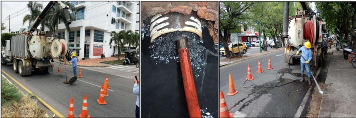
Ilustración 37 Actividades de mantenimiento en redes de alcantarillado sanitario de Yopal
