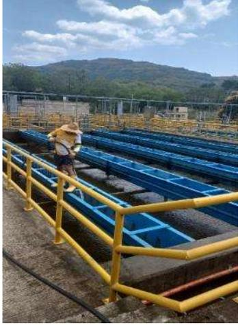
*Ilustración 15 lavado de canaletas y colmenas de la estructura de sedimentación*
