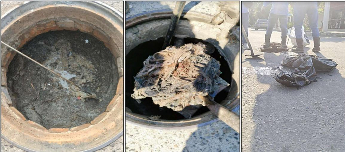
Ilustración 38 Actividades de mantenimiento en redes de alcantarillado sanitario de Yopal
