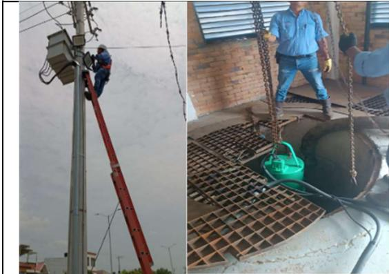
Instalación de electrobomba de 36hp, se baja trac de trasformador de posición tres a uno quedando un nivel de tensión de 480 a 440 voltios
