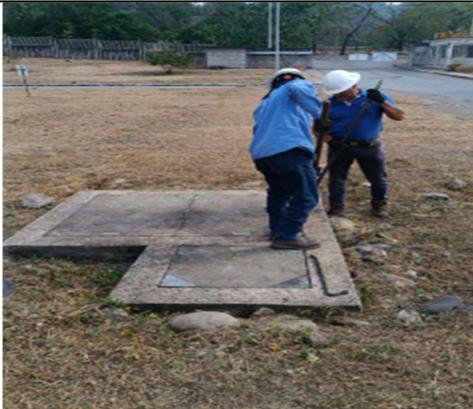
Se continúa con la inspección, limpieza y marcación de cajas de paso eléctricas de la planta definitiva se encuentra algunas cajas llenas de lodo y agua que requieren hacer mantenimiento correctivo.
