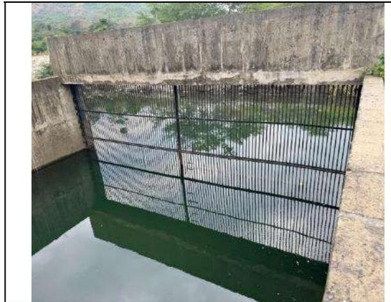
*Ilustración 10 Limpieza de rejillas de retención de sólidos*
