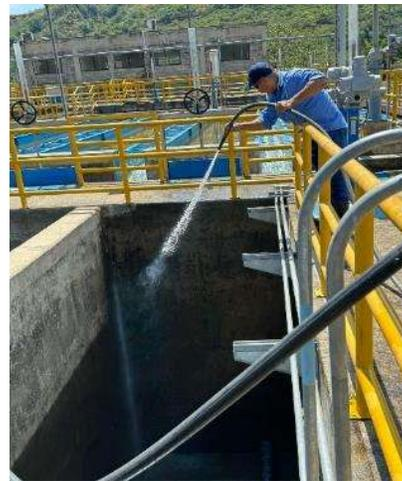
*Ilustración 14 LAVADO DE ESTRUCTURAS DE FILTRACIÓN*
