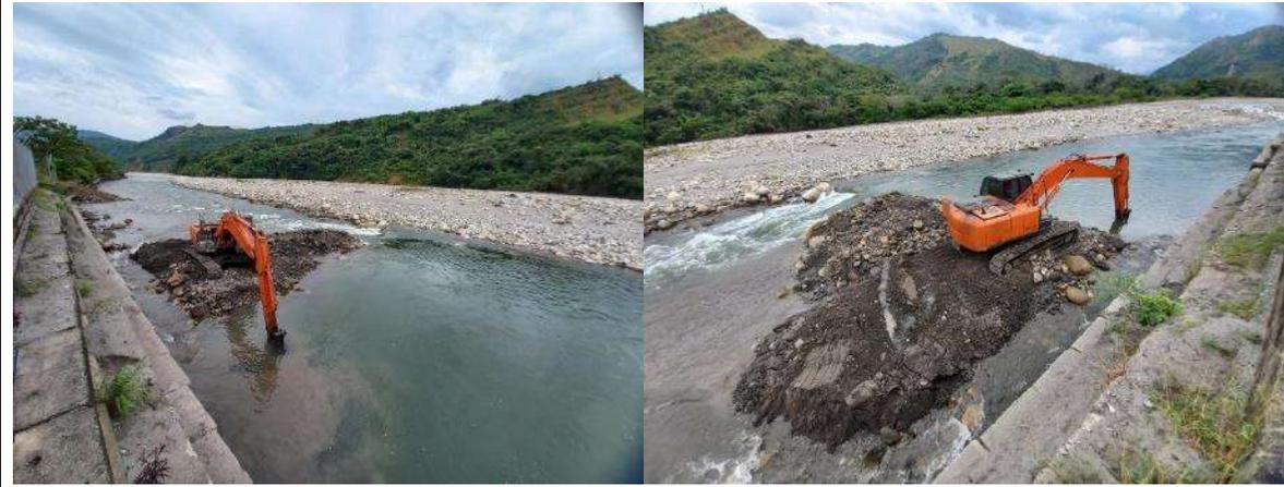
*Ilustración 8 Construcción de Jarillón con material de río para el represamiento/encauzamiento de agua hacia la bocatoma*
