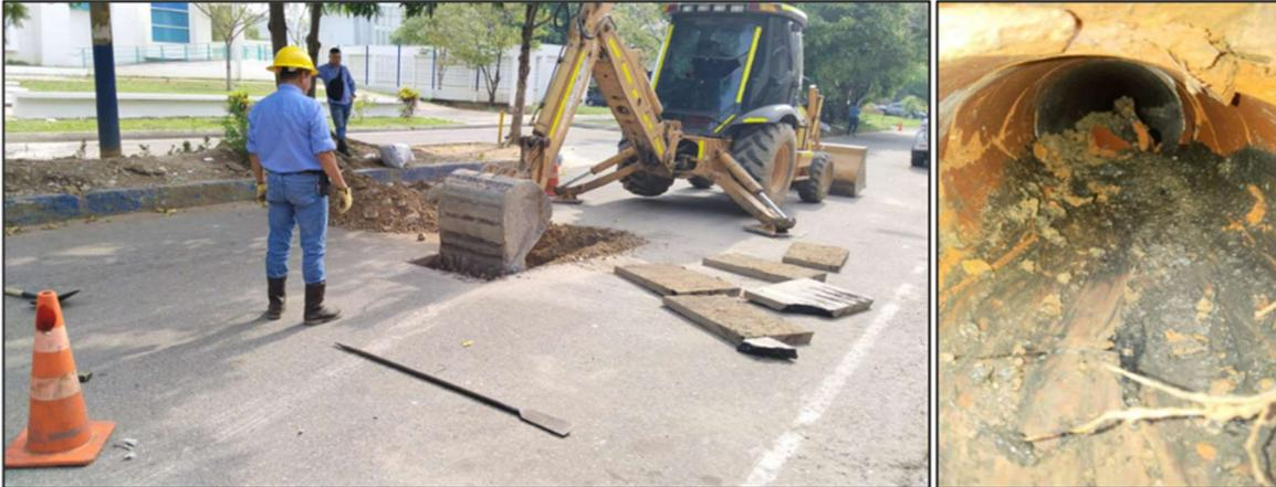
*Ilustración 39 Actividades de mantenimiento en redes de alcantarillado sanitario de Yopal*
