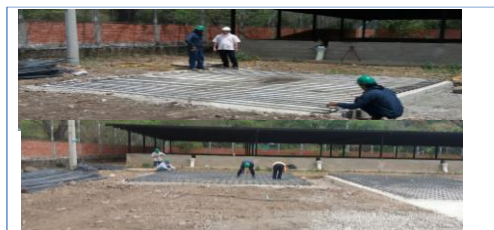
Foto No.10 FIGURADO Y AMARRE DE ACERO 60000
