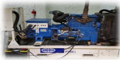
GENERADOR ELECTRICO DE RESPALDO – PLANTA MODULAR
