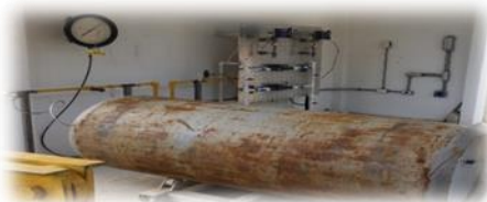
SISTEMA DE DOSIFICACIÓN DE CLORO – PLANTA MODULAR
