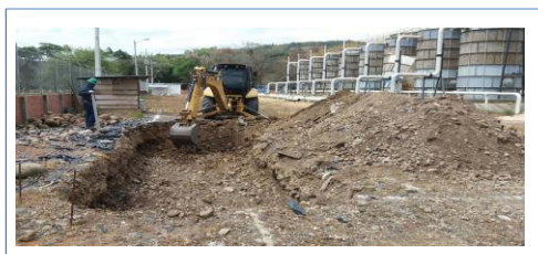
Foto No. 3 EXCAVACIÓN MECÁNICA EN CONGLOMERADO
