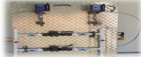
SISTEMA DE DOSIFICACIÓN DE CLORO – PLANTA MODULAR
