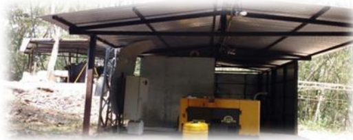
GENERADOR ELECTRICO DE RESPALDO – PLANTA PROVISIONAL LA TABLONA
