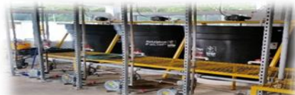
SISTEMA DE DOSIFICACIÓN PLANTA MODULAR
