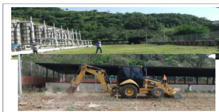
Foto No. 2 LOCALIZACIÓN Y REPLANTEO
