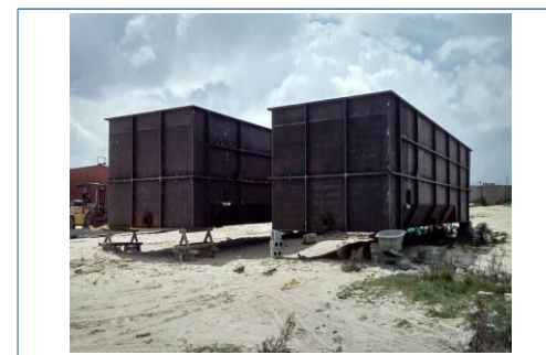
Foto No.14 AVANCE DE CLARIFICADOR No.1 y No.2, EN LA PARTE METALMECANICA.
