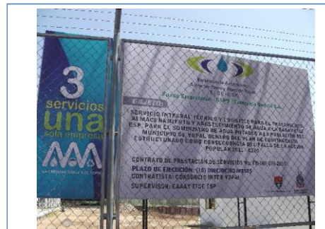
Foto No.15 INSTALACION DE VALLA INFORMATIVA.
