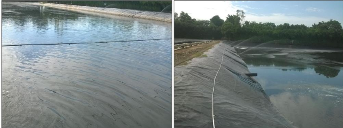
Figura 14: Sistema de goteo y aspersión en lagunas anaeróbicas
