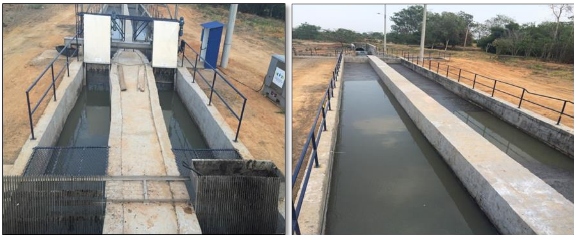
Figura 5: Sistema de Pretratamiento Nuevo (Cribado y Desarenado)
