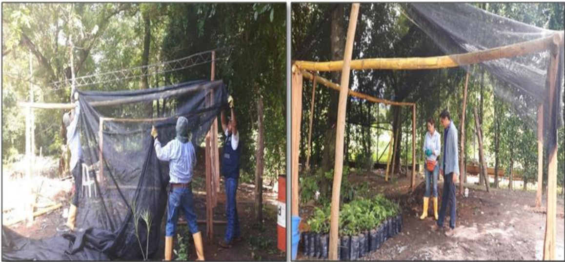
Figura 11: Adecuación de Vivero en la PTAR
