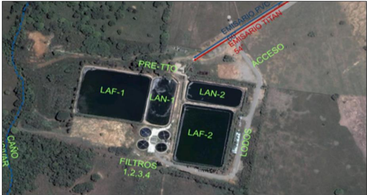
Figura 2: Imagen fotográfica de las instalaciones de la PTAR
