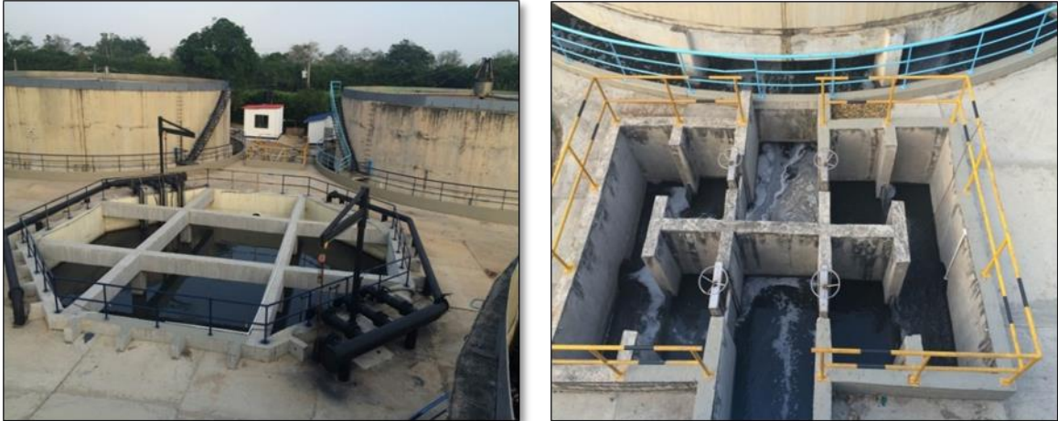
Figura 7: Tanque distribución filtros percoladores y cámara de recirculación.
