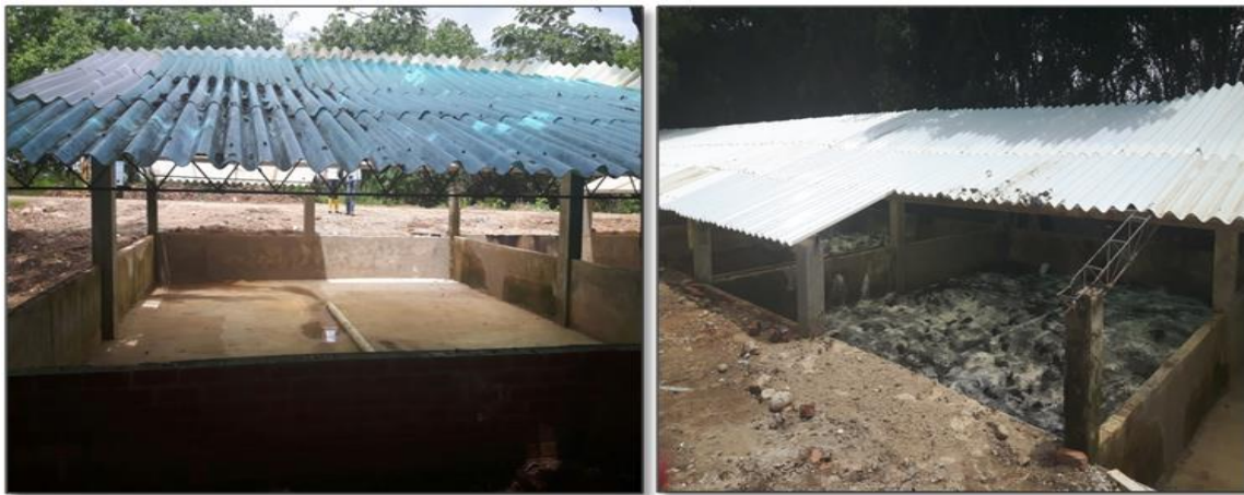
Figura 9: Cámara 1 y 2 lechos de secado
