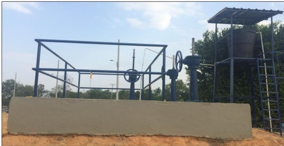
Figura 4: Estructura de Entrada
