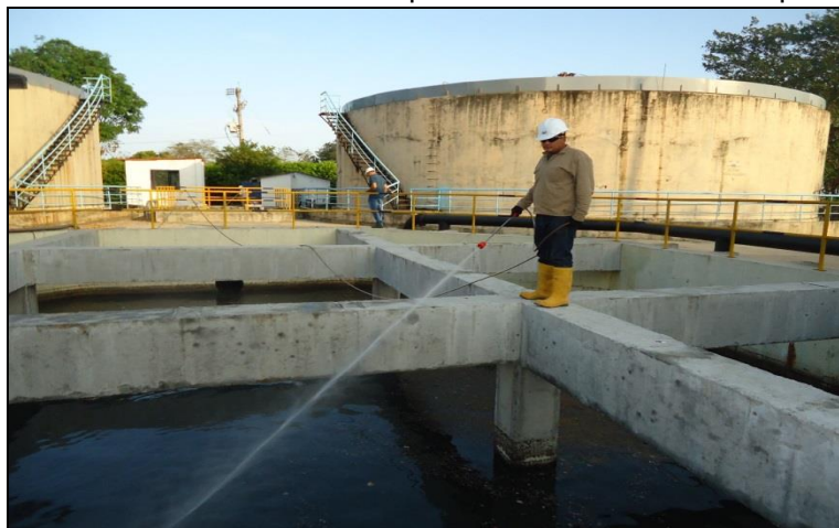
Figura 15: Adición de bioinsumos en tanque de bombeo de filtros percoladores.
