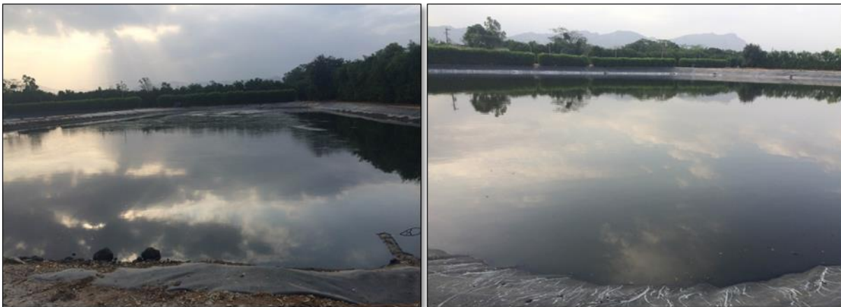
Figura 6: Laguna Anaerobia (Izq.) y Laguna Facultativa (Der.) del tren No 2
