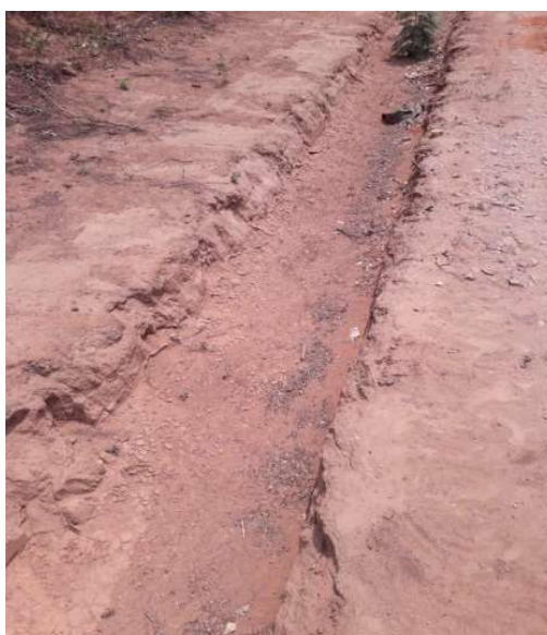
Figura 2. Canal Trinchera N° 13
