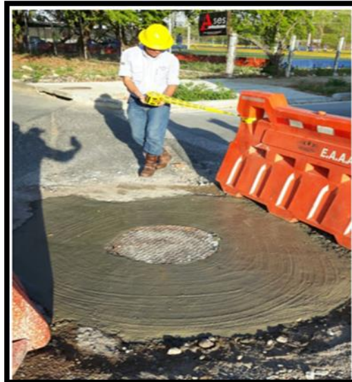
Instalación de Tapas pozos de inspección
