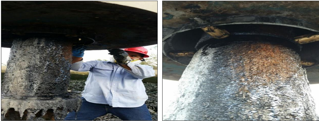
Imagen 2: Cambio de rodamientos filtro N°4.
