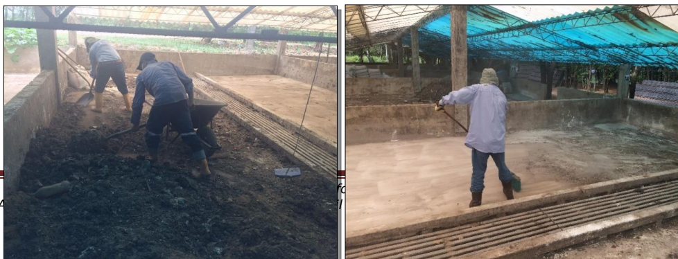
Imagen 4: Retiro de lodos cámaras 3 y 4-Lechos de secado
