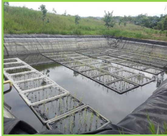
Sistema de fitorremediación en piscina de lixiviados
