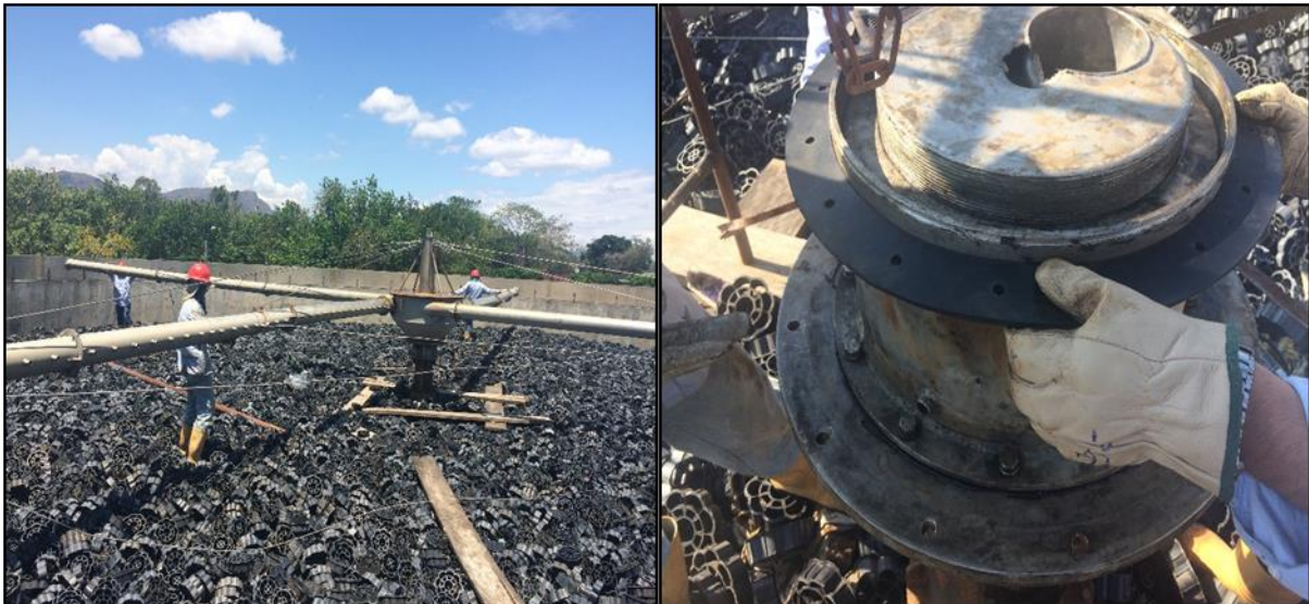
Imagen 1: Mantenimiento Filtros Percoladores 1 y 2
