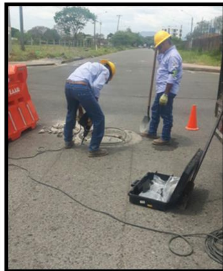
Instalación de Tapas pozos de inspección
