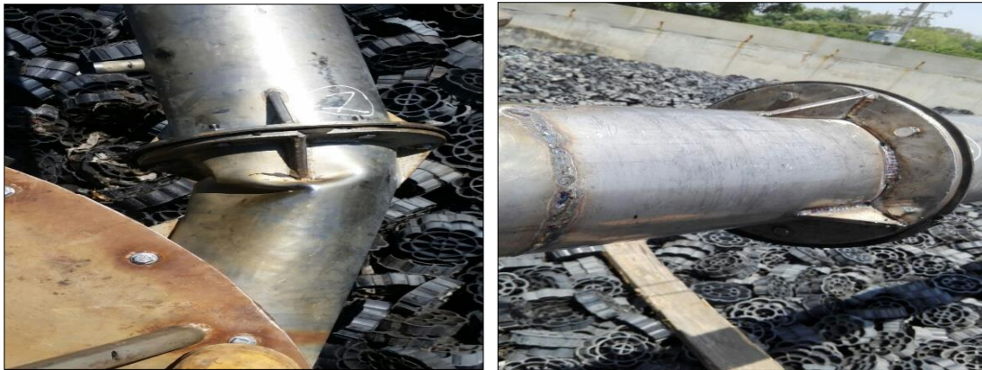
Imagen 3: Arreglo Brazo distribuidor filtro N°1.
